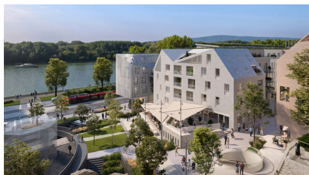
Vydrica, Bratislava, vo výstavbe
