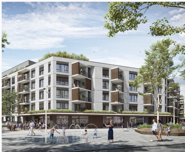
Nesto, Bratislava, prvá budova novej štvrte, vo výstavbe
