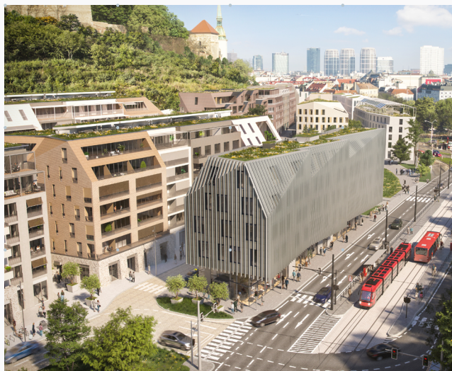
Vydrica, Bratislava, vo výstavbe
