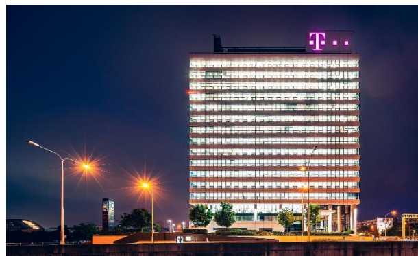
Administrativní budova Forum BC I, Bratislava, SR
