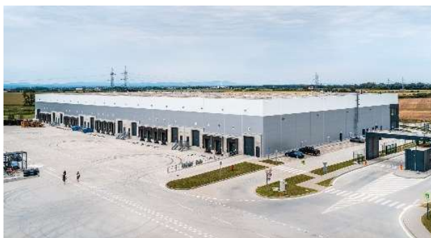
Industrial Park Sereď DC31, Sereď, SR
