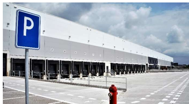
Industrial Park Sereď DC32, Sereď, SR
