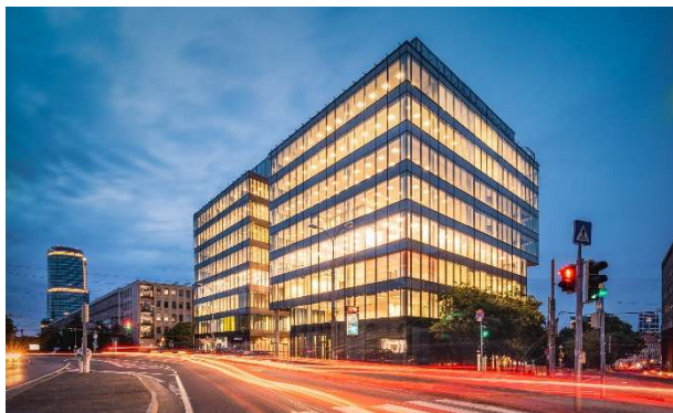
Administrativní budova Park One, Bratislava, SR
