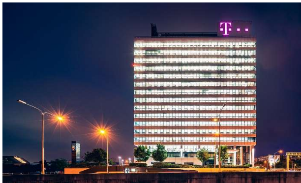
Administrativní budova Forum BC I, Bratislava, SR
