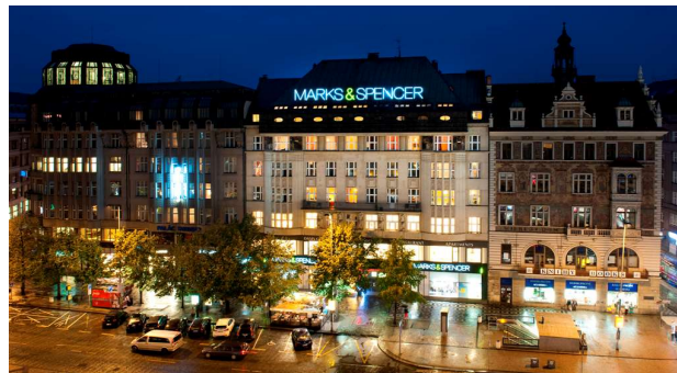
Multifunkční budova Melantrich, Praha, ČR
