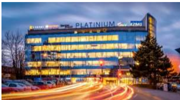
Administrativní budova Platinum, Brno, ČR
