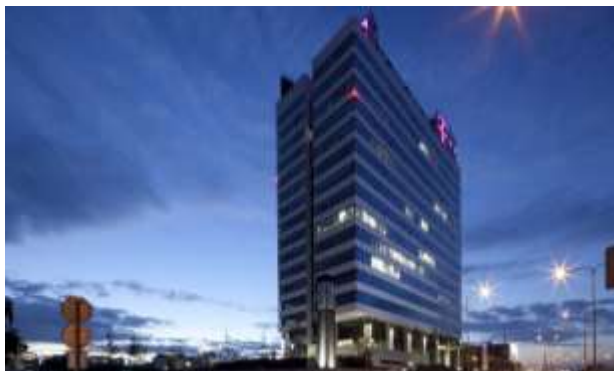
Administrativní budova Forum BC I, Bratislava, SR
