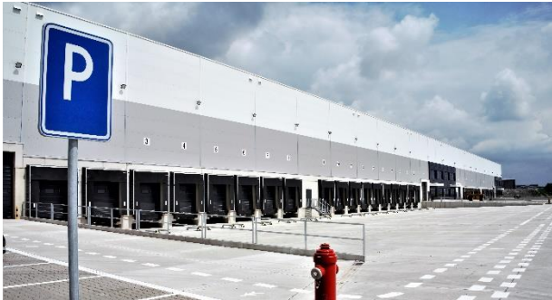
Industrial Park Sereď DC32, Sereď, SR
