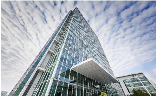
Administrativní budova City Tower, Praha, ČR
