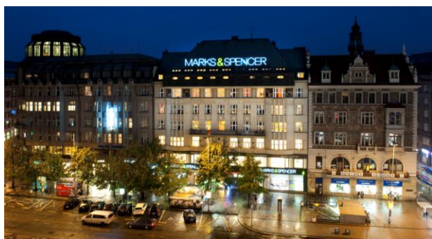
Multifunkční budova Melantrich, Praha, ČR
