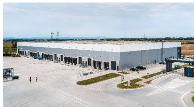
Industrial Park Sereď DC31, Sereď, SR
