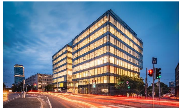
Administrativní budova Park One, Bratislava, SR
