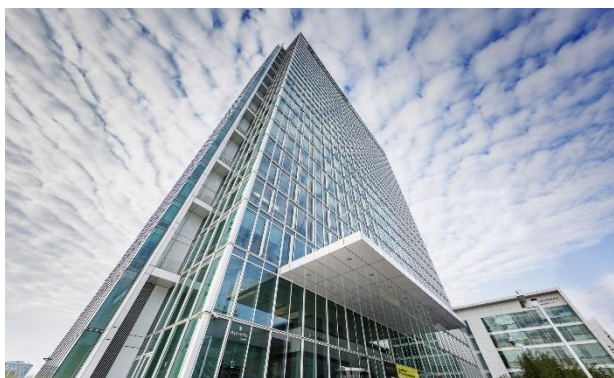
Administrativní budova City Tower, Praha, ČR
