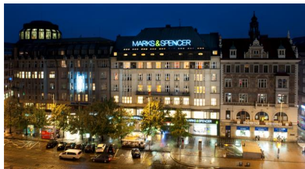
Multifunkční budova Melantrich, Praha, ČR
