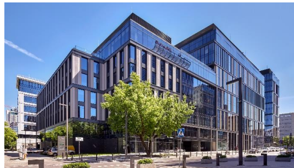
Kancelářská budova Proximo II, Varšava, Polsko
