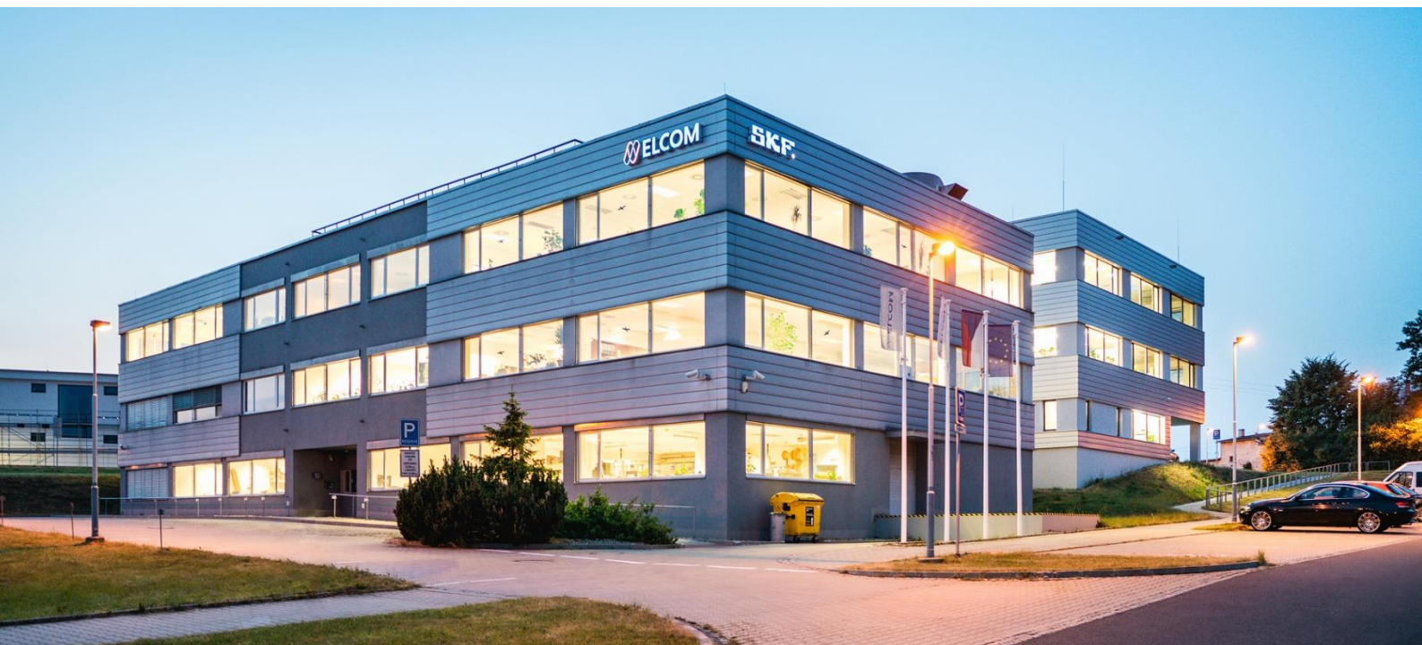
Budova výzkumného a vývojového centra ELCOM, Ostrava, ČR, od 17. 5. v portfoliu REICO ČS LONG LEASE fondu
