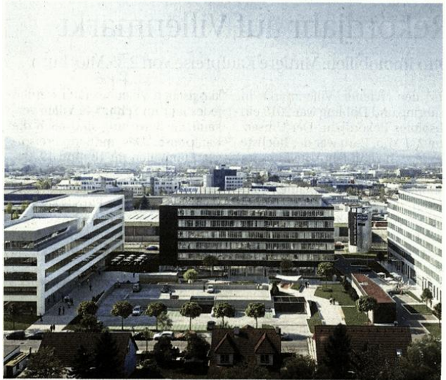
Neue Bürolandschaften: Inno Plaza (oben), Silo Plus (unten). [S+B Group, Erste Group Immorent/brick]
